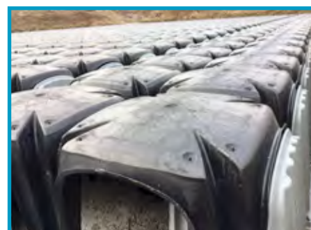
VASCA DI INFILTRAZIONE
