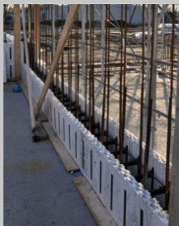
Posizionare l'armatura che, come risultato finale, formerà una maglia composta da ferri orizzontali e verticali assimilabile alla rete elettrosaldata
