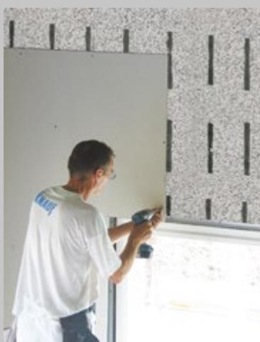
Le staffe del blocco permettono di fissare il rivestimento di finitura interna senza eseguire la struttura apposita
