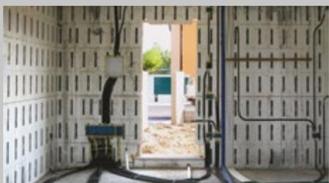
Gli impiantisti eseguono autonomamente, con un coltello caldo, le tracce in maniera sicura e veloce
