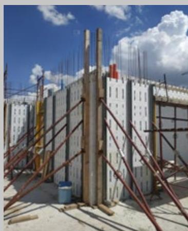
Regolare appena prima del getto l'allineamento e l'appiombo. Gettare utilizzando calcestruzzo S4 (tipo tixotropico, granulometria max inerti 20 mm)
