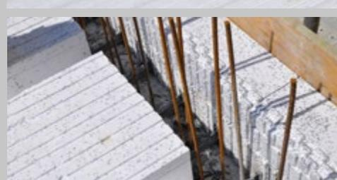
Nel realizzare il solaio non si interrompe la continuità dell'isolamento esterno evitando così ponti termici; la spondina del solaio, inoltre, risulta già eseguita
